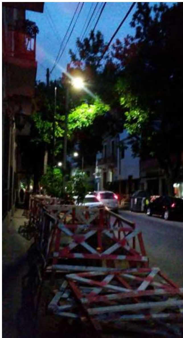
(4) Luego del cambio de luminarias 07-11-2017
